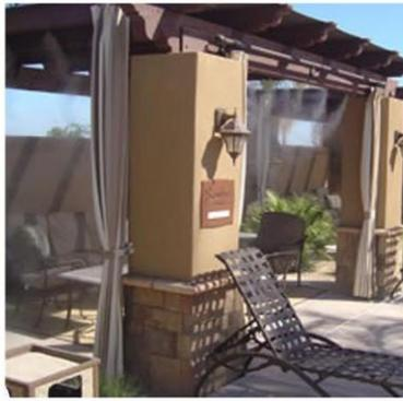
Le Mistyl Eco a été conçu pour rafraîchir une surface allant de 20 à 30 m<sup>2</sup> par rampe de brumatisation.
